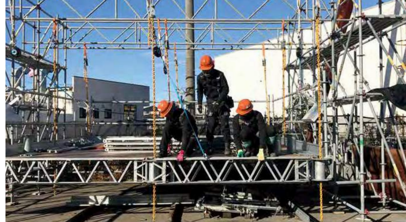
組み立てがシステム化されており、従来の足場と比較して熟練工を必要とせず、施工日数も短縮された
